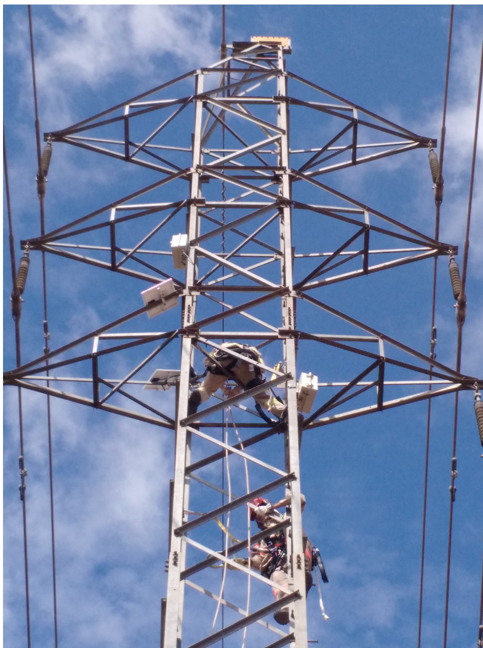
Figura B.4: Sensor em processo de instalação na torre de transmissão.
