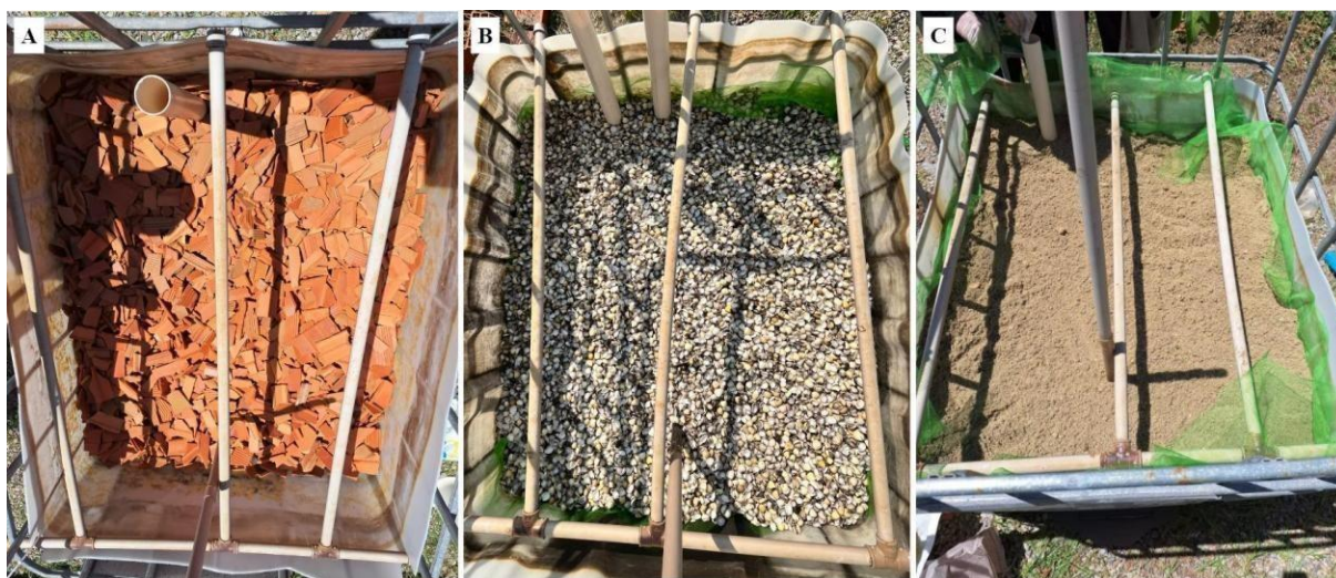
Figura 10 — Camadas de substratos usadas nos wetland construídos
