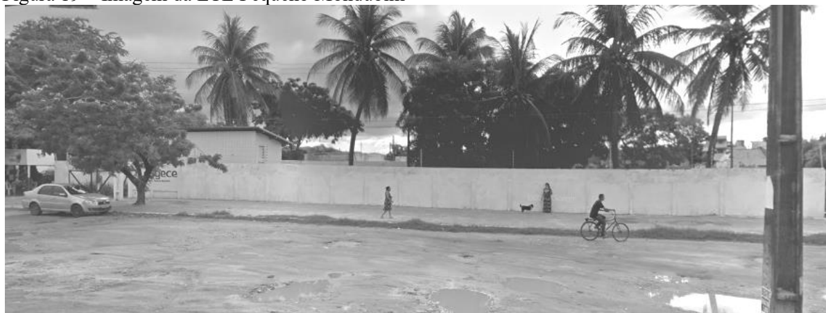
Figura 19 – Imagem da ETE Pequeno Mondubim
