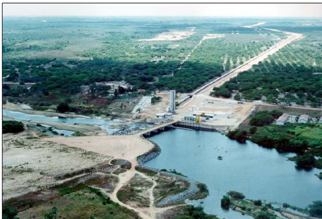
Figura 30 – Barragem do rio Acaraú pelo projeto de abertura de reservatórios e canais de água no perímetro Irrigado do Baixo Acaraú, com destaque para a redução da vazão do rio em 2012.
